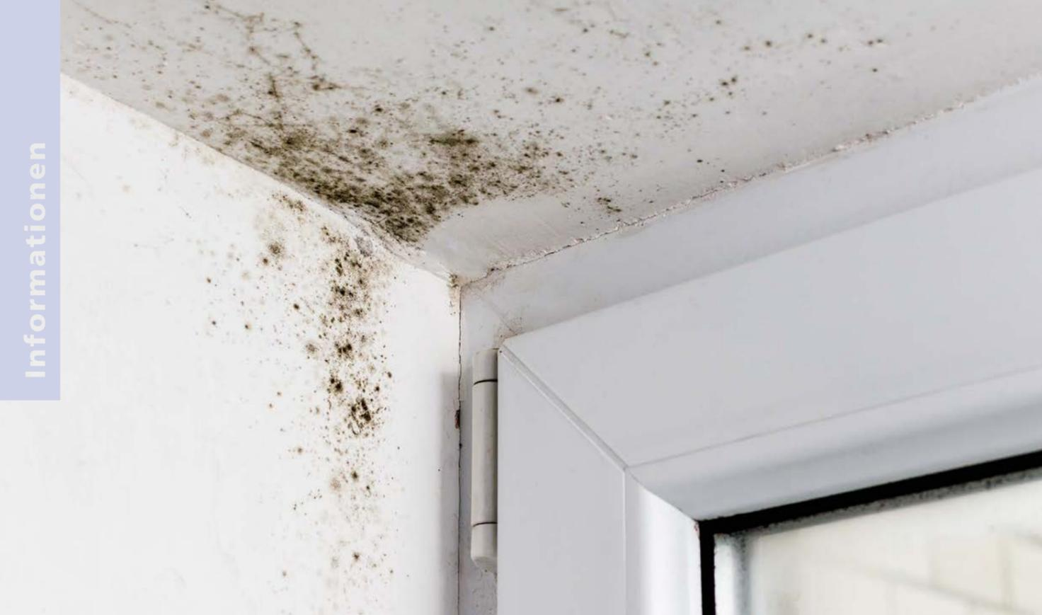
Schimmelbildung durch Kipplüftung
