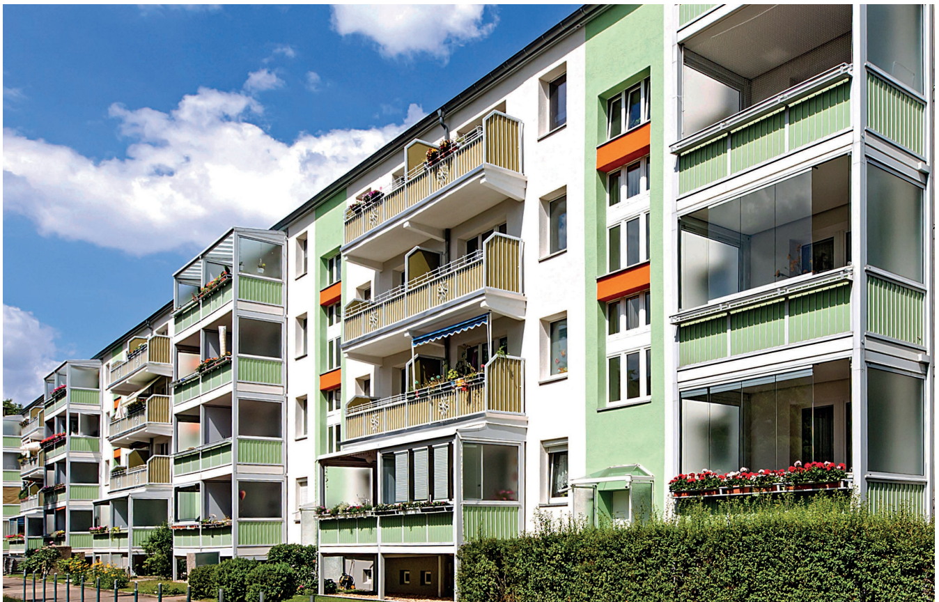
Neue Fassade Sterndamm
